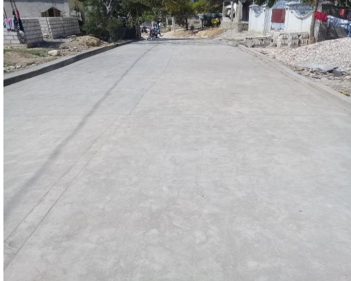
Centre-Ville – Rue Merline
